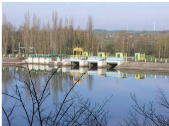
Rys. 2. Widok od strony wody górnej na zaporę i blok upustowy przed katastrofą [4]
