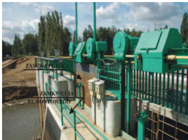
Rys. 5. Widok wlotów do komory turbinowej [6]
