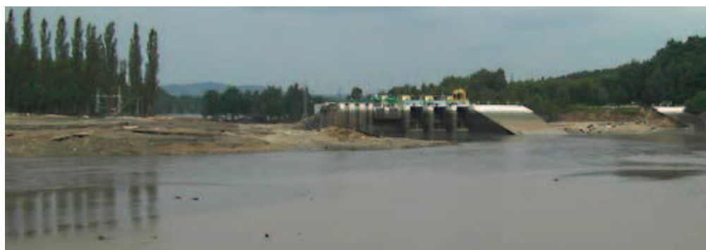
Rys. 1. Stopień wodny Niedów po katastrofie budowlanej w sierpniu 2010 r.
