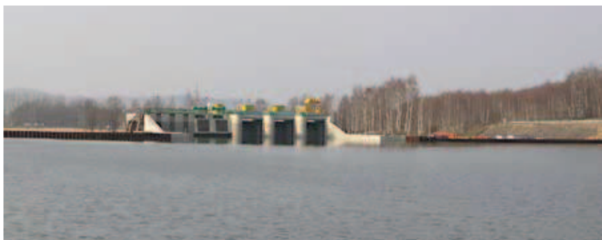
Rys. 8. Stopień wodny Niedów po wybudowaniu grodzi tymczasowej
