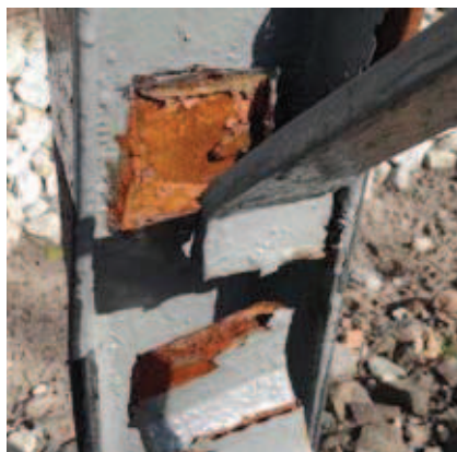
Rys. 6. Szczegóły połączenia w węzłach skratowania z płaskowników na spoiny pachwinowe: a) niezniszczonego, b) zniszczonego
