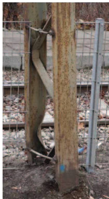
Rys. 5. Uszkodzenia mechaniczne słupów tramwajowej sieci trakcyjnej: a) zdeformowane gałęzie oraz zniszczone połączenia skratowań, b, c) zdeformowane gałęzie w dwóch słupach
