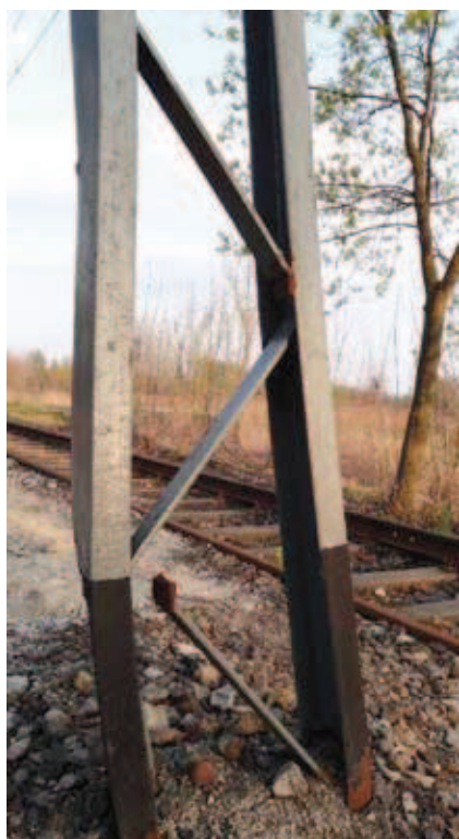
Rys. 5. Uszkodzenia mechaniczne słupów tramwajowej sieci trakcyjnej: a) zdeformowane gałęzie oraz zniszczone połączenia skratowań, b, c) zdeformowane gałęzie w dwóch słupach
