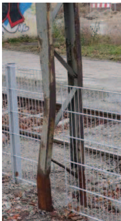
Rys. 5. Uszkodzenia mechaniczne słupów tramwajowej sieci trakcyjnej: a) zdeformowane gałęzie oraz zniszczone połączenia skratowań, b, c) zdeformowane gałęzie w dwóch słupach
