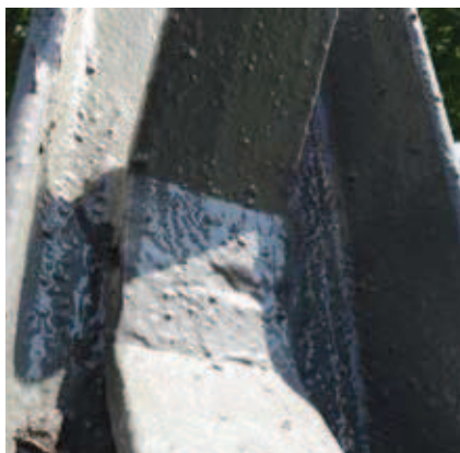
Rys. 6. Szczegóły połączenia w węzłach skratowania z płaskowników na spoiny pachwinowe: a) niezniszczonego, b) zniszczonego
