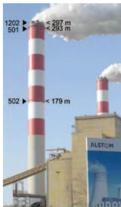
Rys. 1. Lokalizacja 3 anten GPS typu rover na kominie
