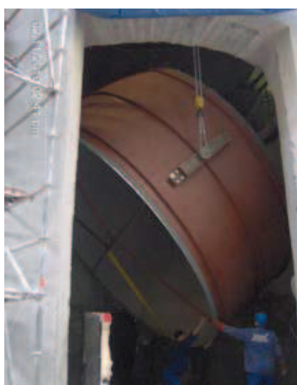
Rys. 9. Montaż carg na starym płaszczu komina (wprowadzanie do wnętrza komina i podciąganie)
