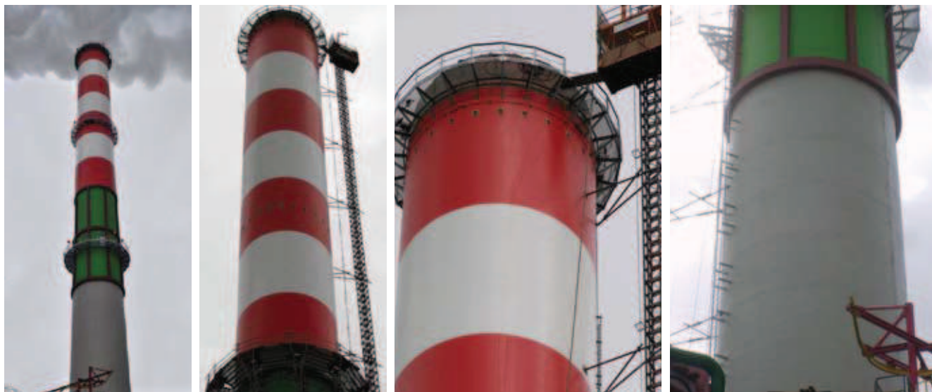
Rys. 10. Komin po modernizacji
