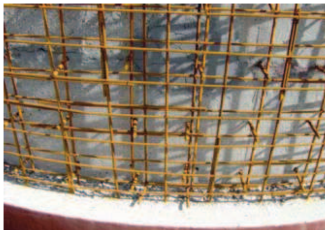
Rys. 4. Zbrojenie środkowego żebra pierścieniowego i zbrojenie pełnej części nowego płaszcza
