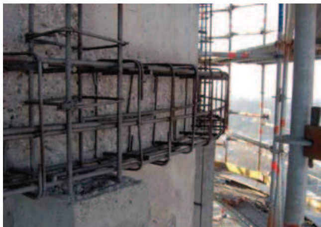
Rys. 4. Zbrojenie środkowego żebra pierścieniowego i zbrojenie pełnej części nowego płaszcza
