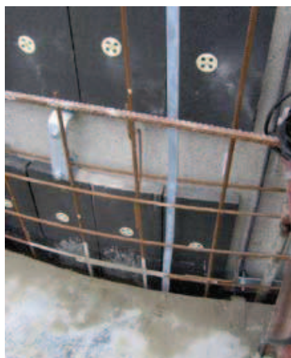
Rys. 8. Foamglas i łączniki mocowane
