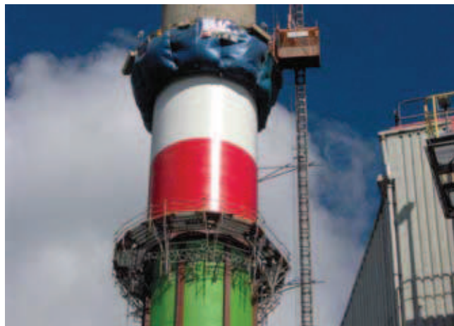
Rys. 6. Betonowanie w ślizgu
