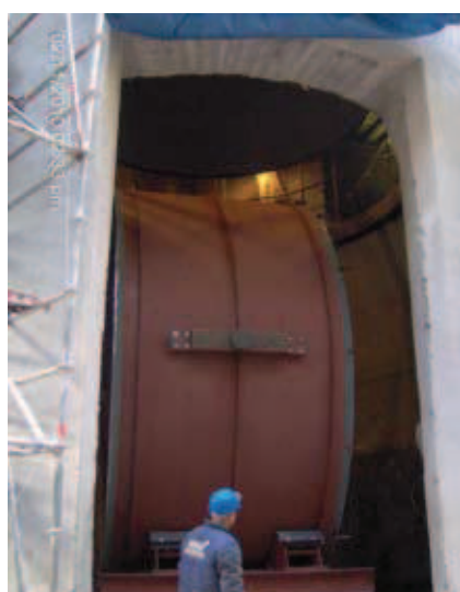
Rys. 9. Montaż carg na starym płaszczu komina (wprowadzanie do wnętrza komina i podciąganie)
