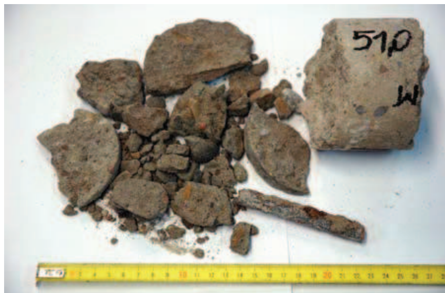
Rys. 3. Rdzeniowa próbka betonowa pobrana na poziomie +51,0 m. Beton rozkruszony i rozwarstwiony. Korozja pręta zbrojeniowego
