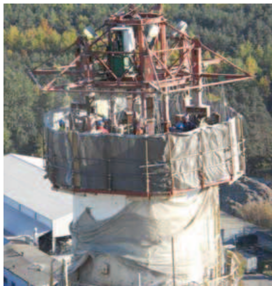
Rys. 5. Wyburzenie komina K2 z zastosowaniem platformy do rozbiórki kominów żelbetowych
