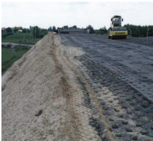
Rys. 5. Formowanie nasypu z popioło-żużli, obwodnica Sochaczewa
