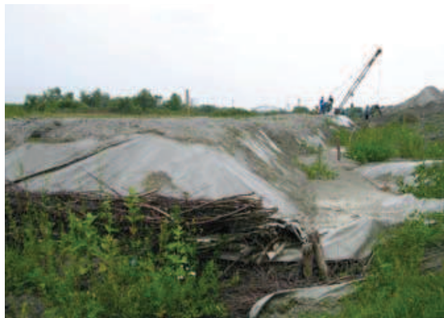
Rys. 4. Formowanie przypory-wału przeciwpowodziowego na materacu faszynowym w otulinie geowłókniny
