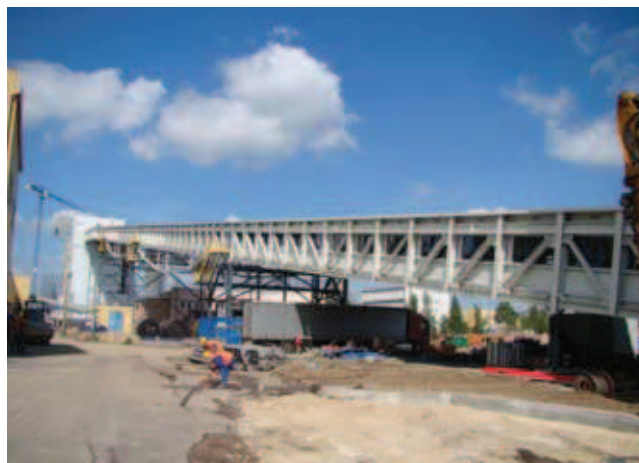
Rys. 1. Widok typowej galerii przenośników taśmowych
