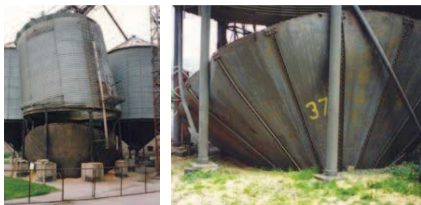
Rys. 3. Przykłady awarii silosów z blach falistych, które rozpoczęły się od oberwania leja [1], [2]
