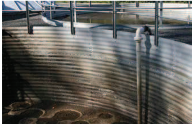
Rys. 5. Ściana zbiornika szlamowego bez żadnych śladów korozji
