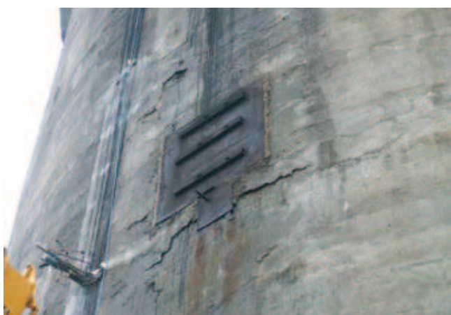
Rys. 3. Wzmocnienie stalowe w miejscu perforacji płaszcza
