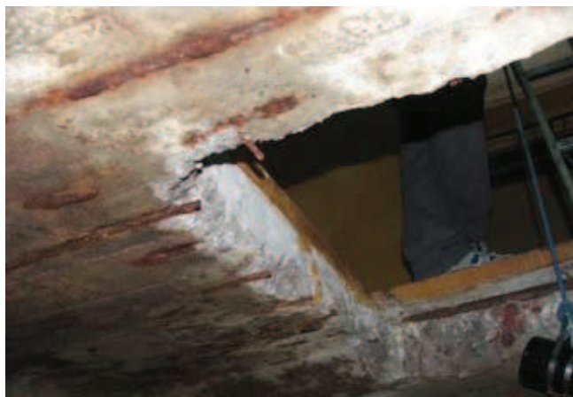
Rys. 5. Stan płyty stropowej w obszarze wykonanych otworów
