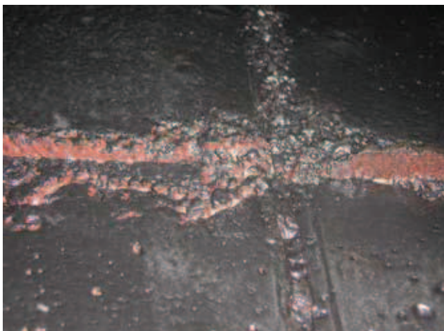
Rys. 5. Nieciągłość powłok zabezpieczających na styku deskowań (raki, nierówności)
