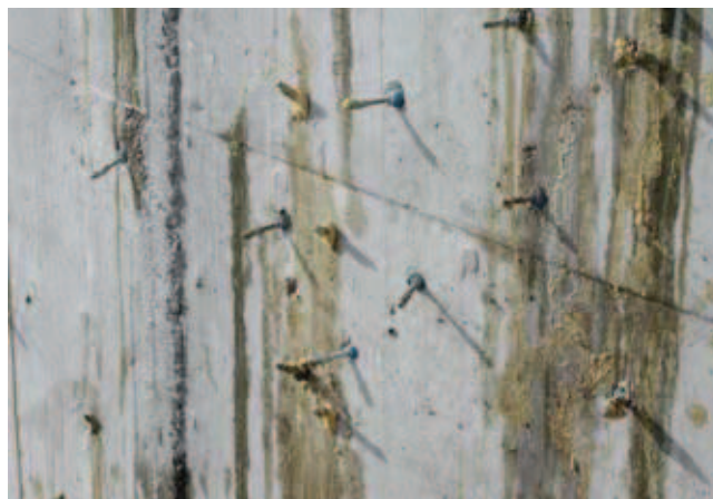
Rys. 4. Widok na ścianę zbiornika (widoczne pakiery służące do iniekcji)
