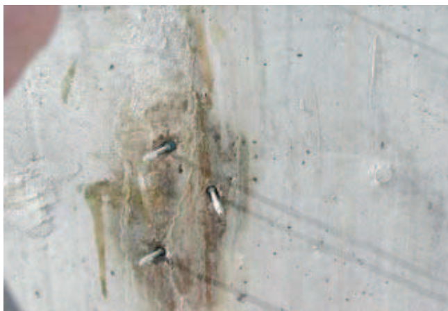
Rys. 2. Widok ściany zbiornika (widoczne przecieki)
