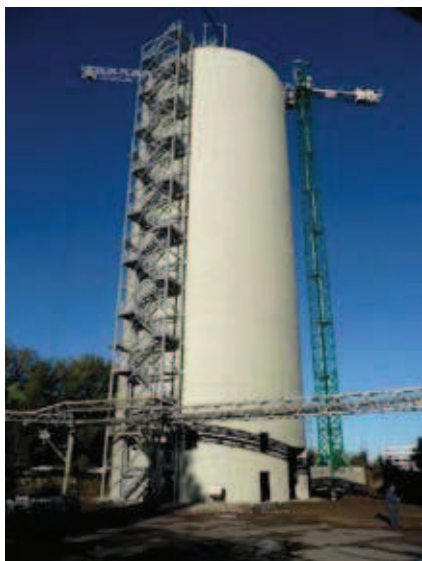
Rys. 9. Wykonany silos na popiół lotny: widok zewnętrzny oraz płyta denną ze stożkiem stalowym w widoku z góry
