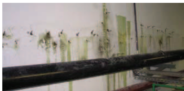
Fot. 5. Naprawy przecieków znajdujących się w poziomym szwie roboczym
