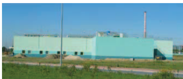
Fot. 1. Elewacja wschodnia
