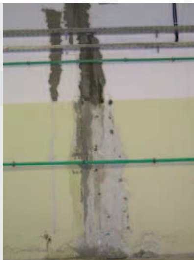
Fot. 2. Wykonana iniekcja rys pionowych
