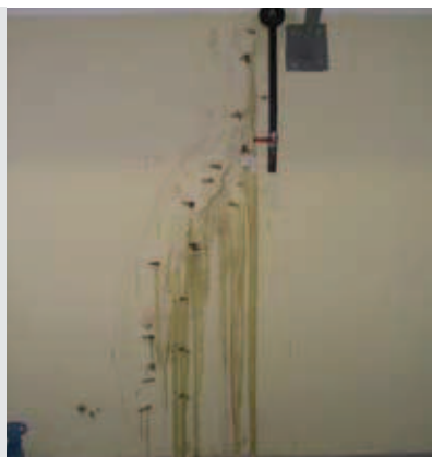
Fot. 3. Naprawy przecieków w pobliżu spustu z osadnika „A”
