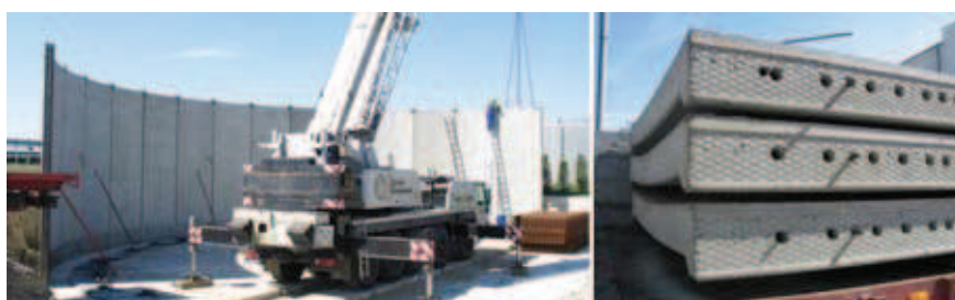
Rys. 1. Montaż prefabrykowanej ściany zbiornika
