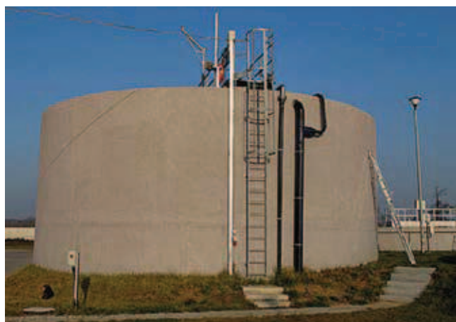
Rys. 2. Widok ogólny komory stabilizacji osadu
