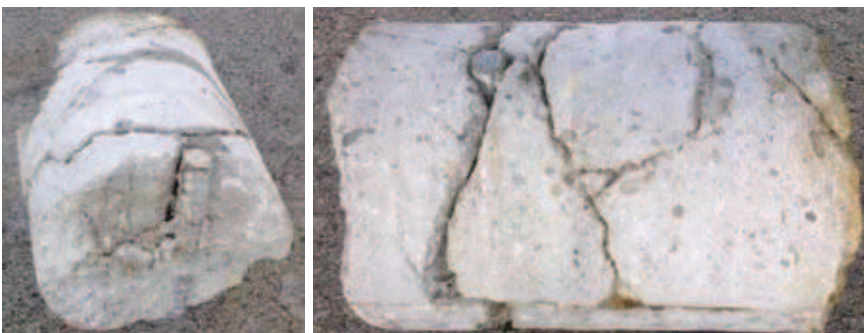
Rys. 8. Łączenie warstw wylewanego betonu w przerwie technologicznej
