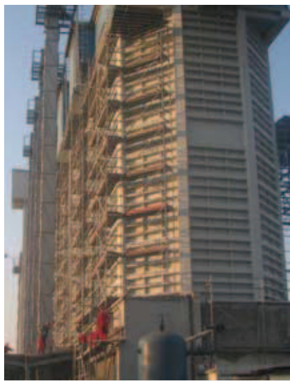
Rys. 1. Remont silosu prefabrykowanego
