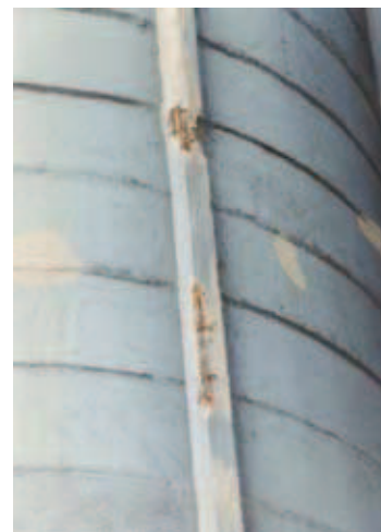
Rys. 7. Uszkodzony pilaster
