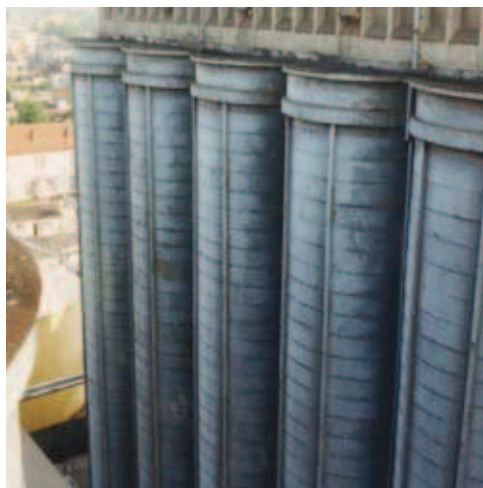
Rys. 6. Bateria silosów zblokowanych
