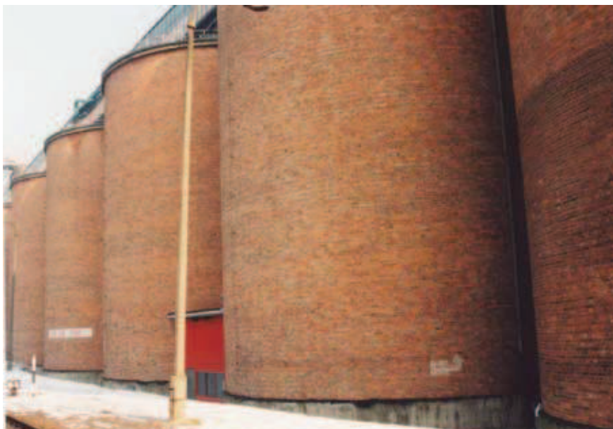
Rys. 10. Silosy ceramiczne w Zakładach Tłuszczowych
