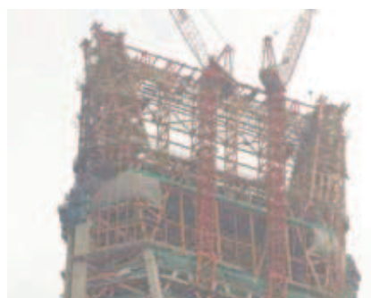
Rys. 15. Realizacja konstrukcji zwieńczenia [19]
