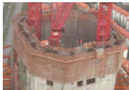
Rys. 11. Wznoszenie trzonu przy zastosowaniu samowspinających urządzeń formujących i rusztowań [19]
