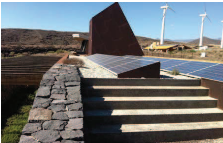
Rys. 5. Compacta, architekt Fernando de Retes Aparicio z zespołem z Hiszpanii, Pow. uż. 123 m 2 + taras 123 m 2 , pow. kolektorów 2,26 m 2 dla cwu. Budynek produkuje 5100 kWh w roku
