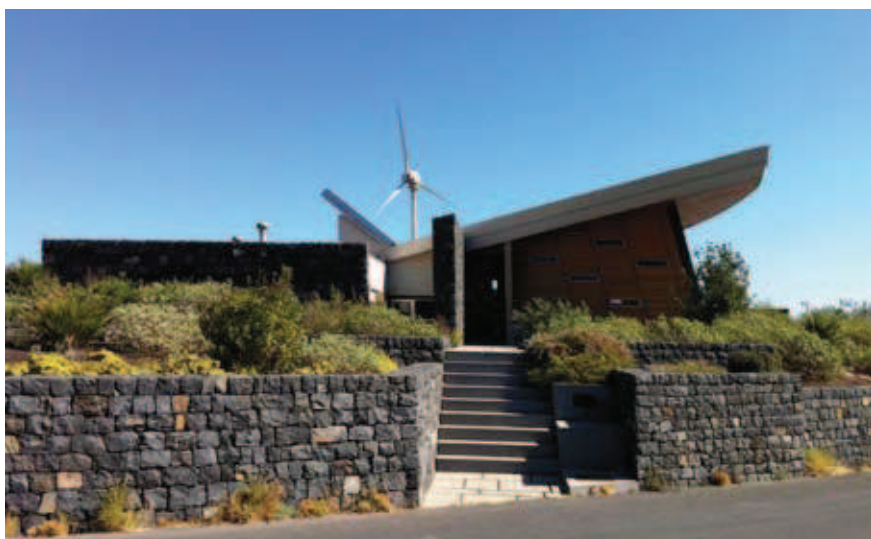
Rys. 2. La Geoda, architekt Eduardo Vadillo Ruiz z Hiszpanii. Pow. uż. 150 m 2 + taras 32 m 2 , pow. kolektorów 5,26 m 2 dla cwu. Budynek produkuje 5100 kWh w roku
