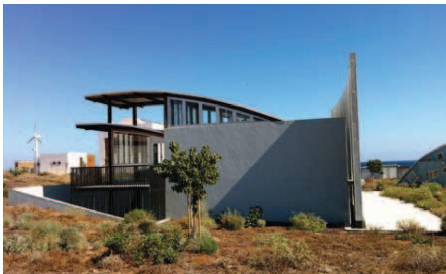
Rys. 6. La Religa, architekt Nahim Dagdug z zespołem z Meksyku. Pow. uż. 194 m 2 + 128 m 2 taras, solar na dachu o pow 2.26 m 2 dla cwu; budynek produkuje 20223 KWh w roku
