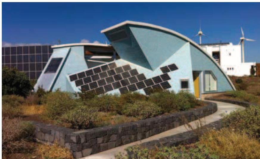
Rys. 4. El Cangrejo, architekt David Dobereiner i Dan Chin z USA. Pow. uż. 129 m 2 + taras 18 m 2 , pow. kolektorów 5,26 m 2 dla cwu. Budynek produkuje 2584 kWh w roku
