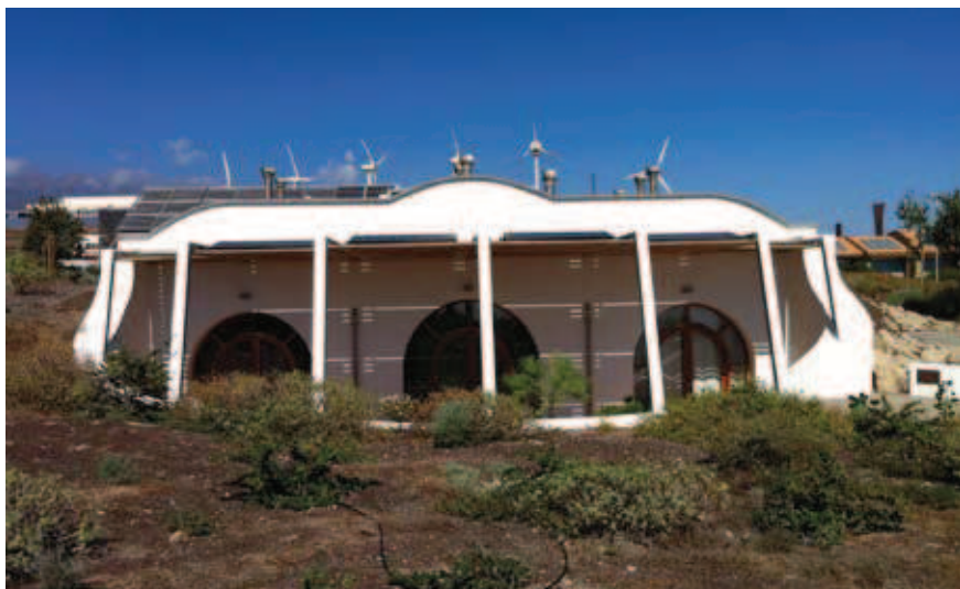
Rys. 4. Las Bóvedas, architekt Jaime Navascues Lacourly z Hiszpanii. Pow. uż. 124 m 2 + taras 48 m 2 , pow. kolektorów 7,09 m 2 dla cwu. Budynek produkuje 4420 kWh w roku
