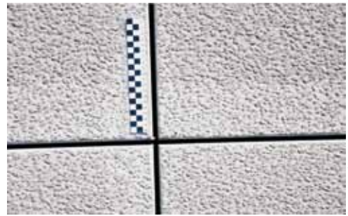
Fot. 6. Wykonanie nawierzchni betonowej – nadanie makrotekstury poprzez odsłonięcie kruszywa („szcztokowanie”) w celu uzyskania wymaganej szorstkości oraz gotowa nawierzchnia betonowa wykonana w technologii ptukanego betonu
