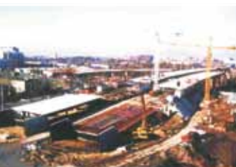
Fot. 2. Budowa i widok ogólny estakady Gądów we Wrocławiu
