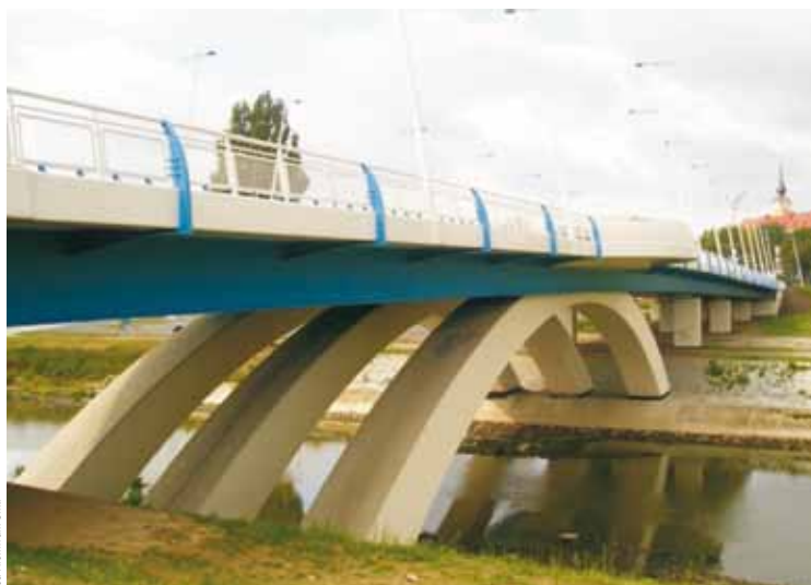
Fot. 3. Budowa i wygląd końcowy pierwszego w Polsce wykonanego całkowicie w technologii betonu SCC mostu Zamkowego w Rzeszowie
