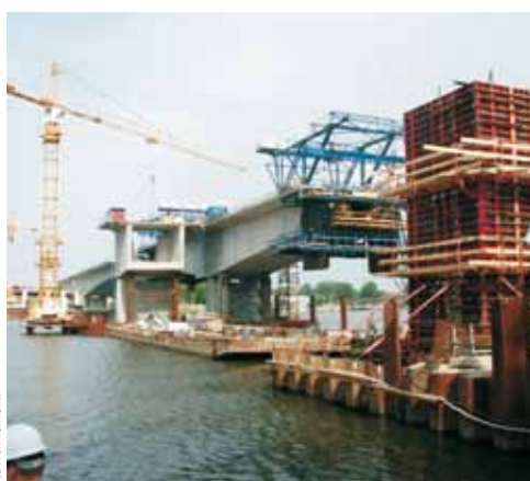
Fot. 4. Budowa i efekt końcowy: most Rędziański – drogowy most wyciągowy nad Odrą, będący częścią autostrady A8 (autostradowej obwodnicy Wrocławia – AOW). Projekt mostu: Zespół Badawczo-Projektowy „Mosty-Wrocław” pod kierownictwem prof. Jana Biliszczuka
