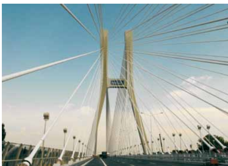
Fot. 4. Budowa i efekt końcowy: most Rędziański – drogowy most wyciągowy nad Odrą, będący częścią autostrady A8 (autostradowej obwodnicy Wrocławia – AOW). Projekt mostu: Zespół Badawczo-Projektowy „Mosty-Wrocław” pod kierownictwem prof. Jana Biliszczuka
