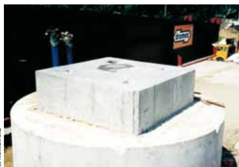
Fot. 1. Ciosy podłożyskowe mostu kolejowego w Miłówce wykonane z betonu modyfikowanego domieszkami na bazie technologii PCE
