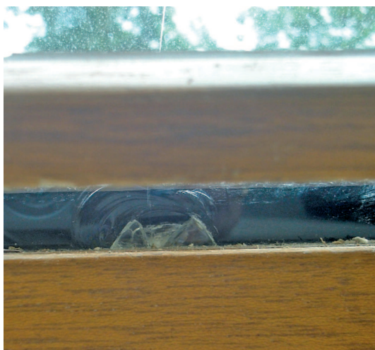
Ryc. 5. Odpryski na krawędziach szyb zespolonych
