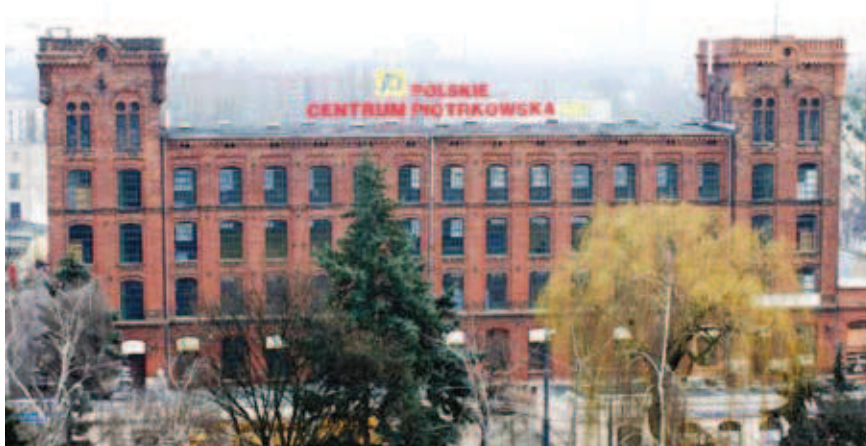
Rys. 19. Budynek dawnej Fabryki Spółki Akcyjnej Wyróbów Bawełnianych i Wełnianych Markusa Silbersteina w Łodzi przy ul. Piotrkowskiej 250 wzniesionej w latach 1894÷1896
