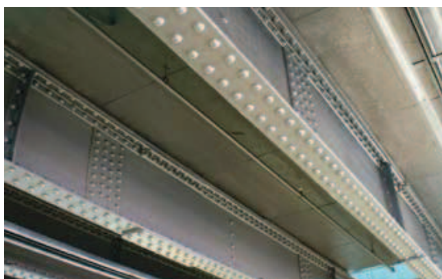
Rys. 17. Stalowe belki pod basenem w Hotelu Andel's w Łodzi
