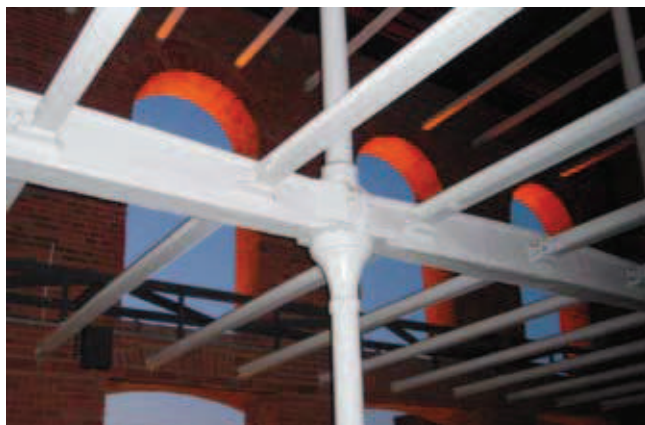
Rys. 16. Stalowe żebra wykonane z szyn kolejowych w jednym z budynków Manufaktury w Łodzi
