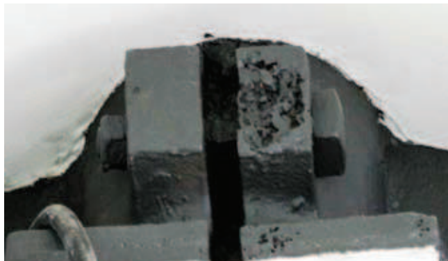
Rys. 11. Niedoskonałości odlewnicze dźwigarów żelwnych
