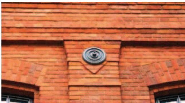
Rys. 13. Żeliwny element kotwiący podciągi stropów – Hotel Andel's w Łodzi
