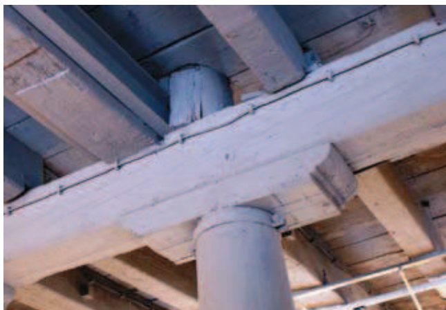
Rys. 2. Detale drewnianej konstrukcji Białej Fabryki
