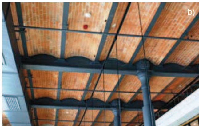
Rys. 8. Szkielet żeliwno-stalowy w budynku bytej przędzalni Poznańskiego: a) w trakcie robót adaptacyjnych, b) po zakończeniu robót – strop nad parterem w pomieszczeniach restauracyjnych hotelu Andel's
