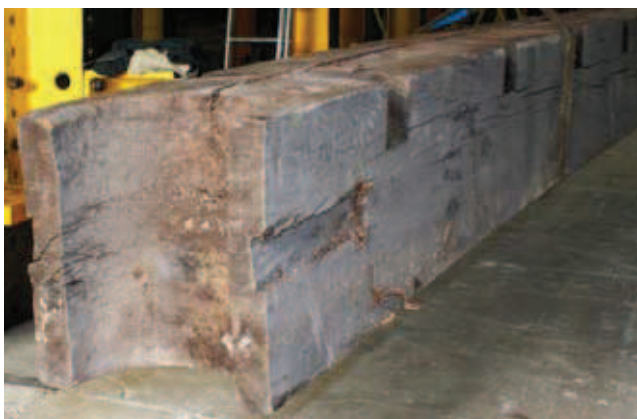
Rys. 4. Drewniany podciąg przystosowany do oparcia na żelaznym słupie
