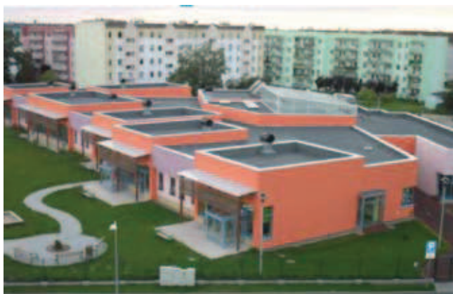
Fot. 4. Widok przedszkola z umieszczonymi kolektorami słonecznymi na dachu (2 baterie po 6 sztuk o łącznej powierzchni 32,0 m 2 )
