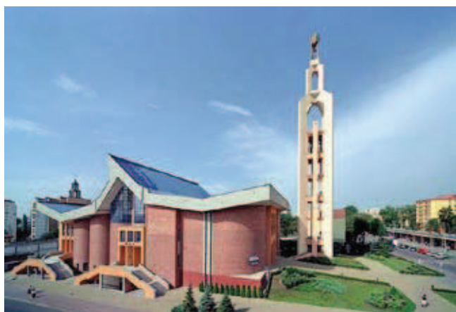
Fot. 2. Instalacja fotowoltaiczna na dachu Sanktuarium w Jaworznie
