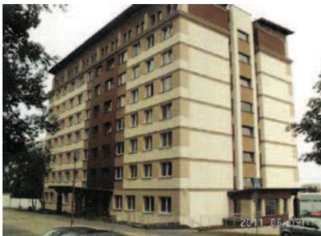
Fot. 1. Budynek z wielkiej płyty po renowacji i zmniejszeniu jego wysokości o trzy kondygnacje
