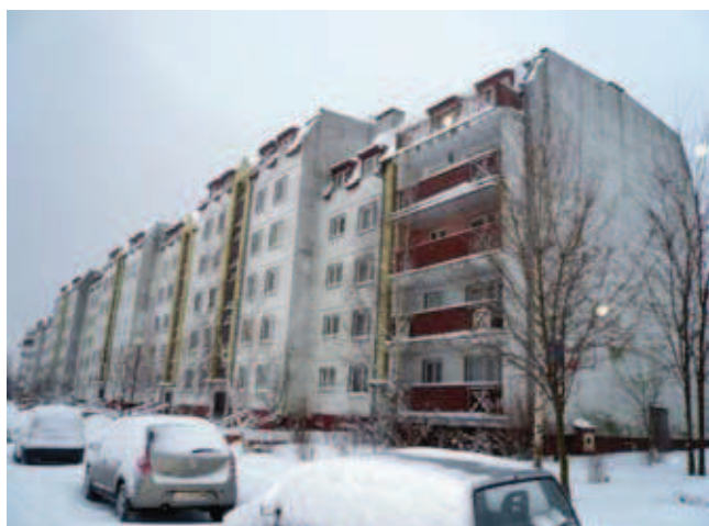
Rys. 4. Widok narożnika północno-wschodniego przed modernizacją, stan grudzień 2010 r.
