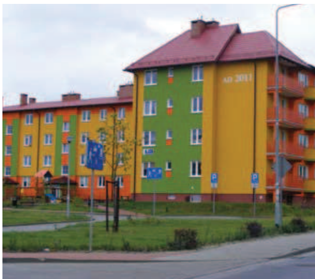
Fot. 3. Przesadna jaskrawość faktur budynków mieszkalnych ma negatywny wpływ na samopoczucie mieszkańców i wrażenia przechodniów
