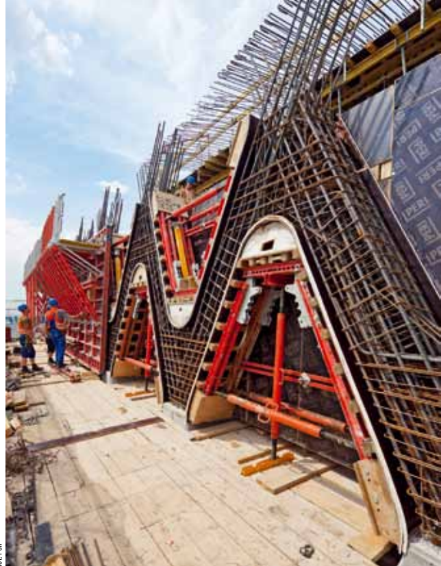
Fot. 1. Deskowanie specjalne ściany z betonu licowego
