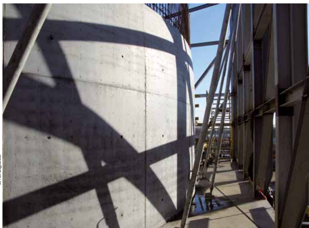
Fot. 5. Fragment kopuły planetarium CN Kopernik w Warszawie, w trakcie realizacji
