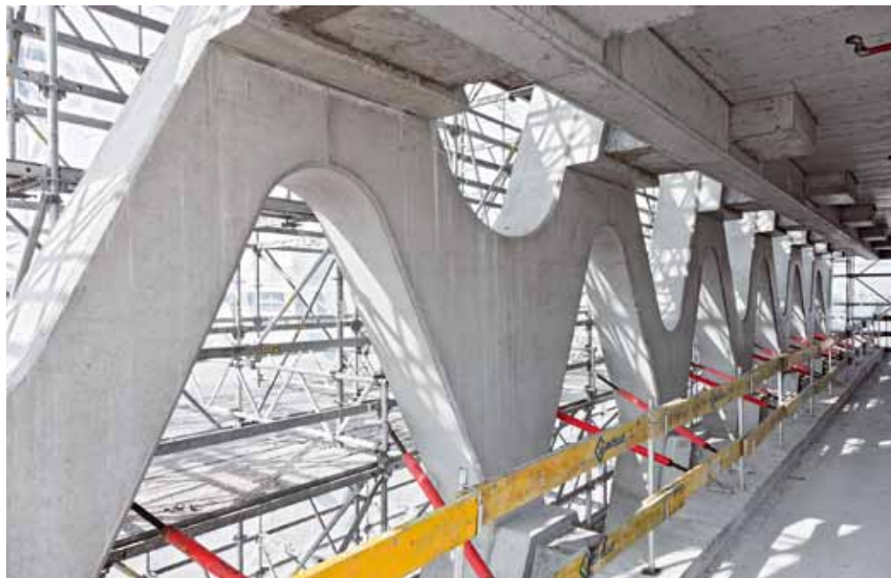
Fot. 2. Ściana z betonu licowego po rozdeskowaniu. Prosta Tower w Warszawie
