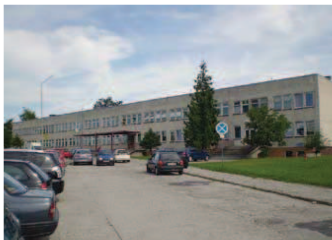
Rys. 1. Gubin. Budynek użyteczności publicznej z kotłownią na paliwo stałe, 1975–80
