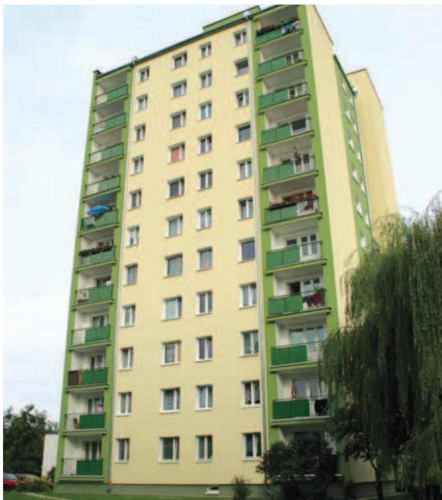
Rys. 5. Widok elewacji północno-zachodniej po termomodernizacji
