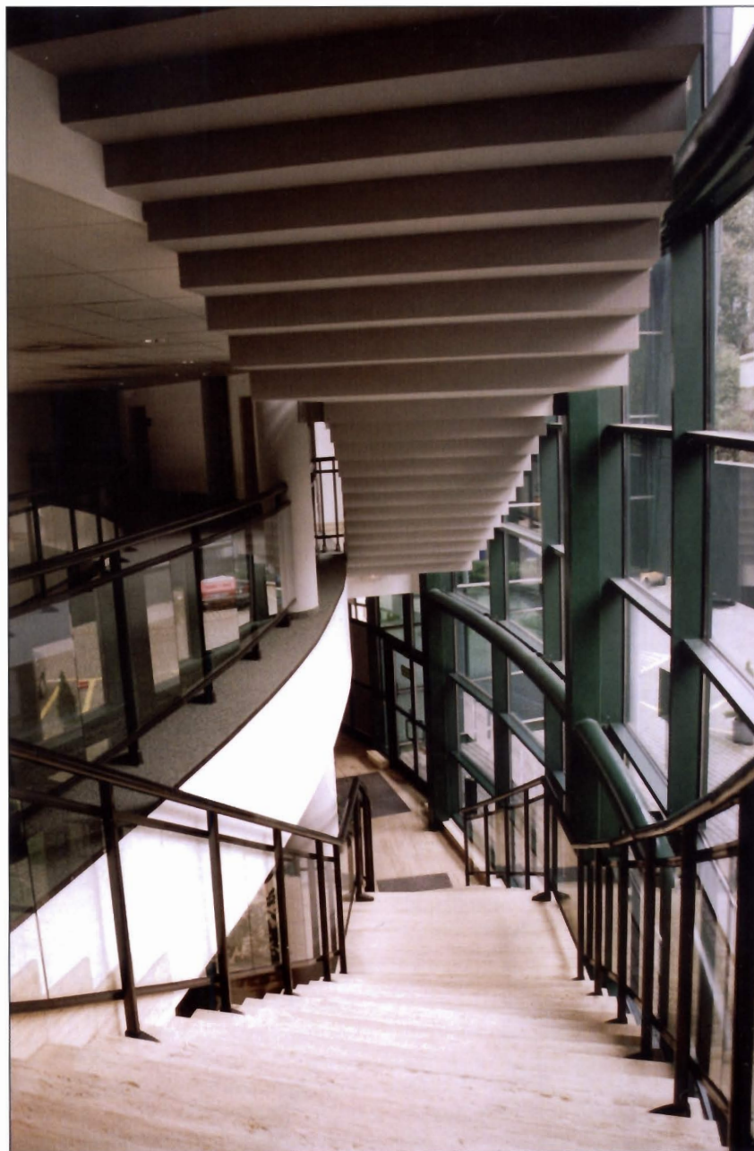
Schody w budynku Radia Kraków wykonane z betonu klasy B100
