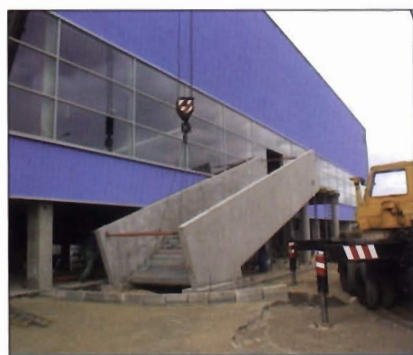
Fot. 1 Prefabrykowane schody żelbetonowe
