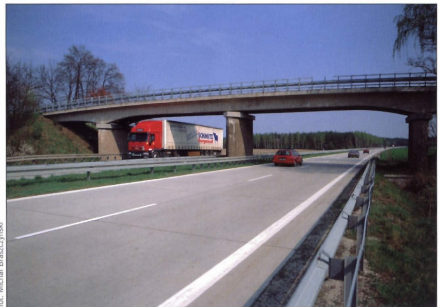
Betonowy odcinek autostrady A12 Golnice – Krzywa
