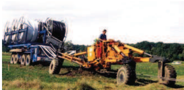
Rys. 7. Wbudowywanie kilku przewodów kablowych jednocześnie, z bębnow zainstalowanych na osobnym środku transportowym [2]
