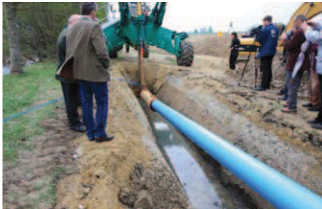
Rys. 4. Wykop początkowy, w którym rozpoczyna się wbudowywanie przewodów podziemnych metodą pługoukładania [4]
