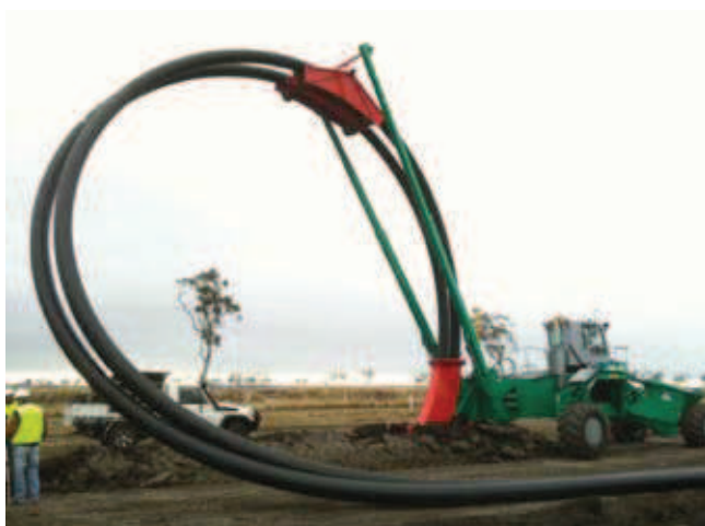
Rys. 6. Prowadnica rur zainstalowana na wysięgniku pługa [4]
