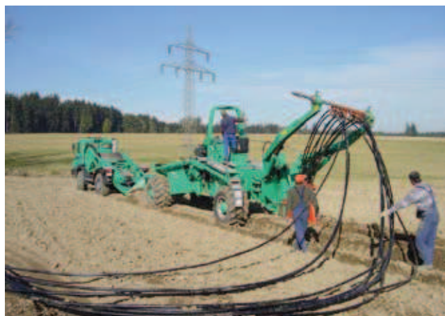
Rys. 8. Prowadnica umożliwiająca układanie wiązki przewodów [4]
