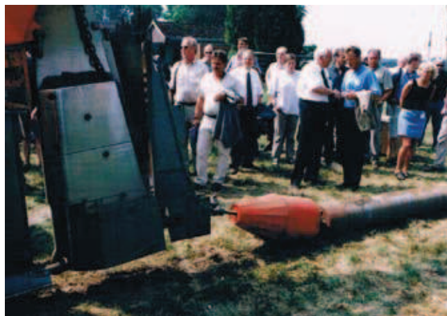
Rys. 11. Głowica wciągająca przewód z żeliwa sferoidalnego, zamocowana bezpośrednio za lemieszem pługa (zdjęcie własne)
