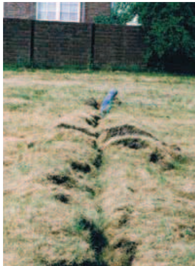
Rys. 14. Niewielkie naruszenie struktury terenu w miejscu ułożenia przewodu metodą pługoukładania (zdjęcie własne)
