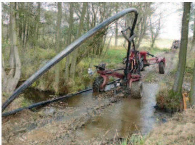
Rys. 13. Układanie rurociągu pod korytem rzeki [2]
