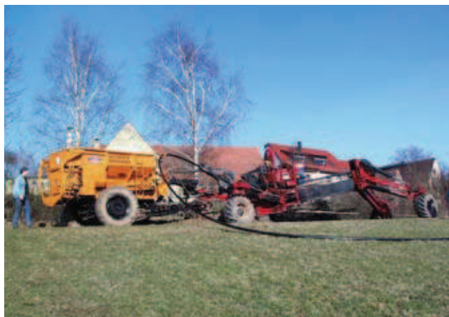
Rys. 9. Wbudowywanie przewodów podziemnych z jednoczesnym wykonywaniem obsypki piaskowej [2]
