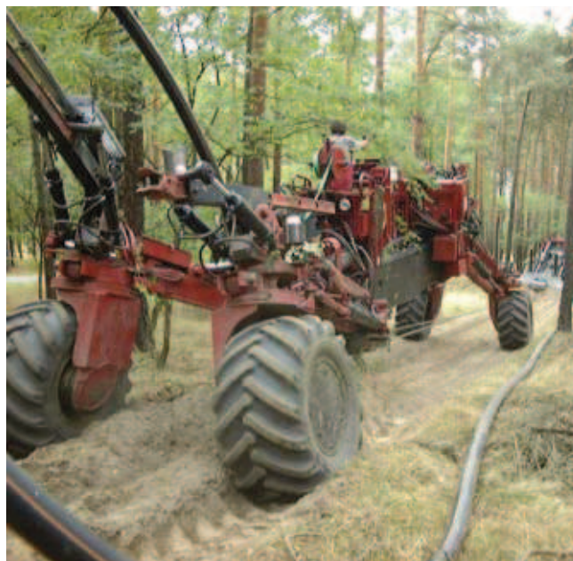
Rys. 15. Wbudowywanie przewodu podziemnego na terenie leśnym [2]
