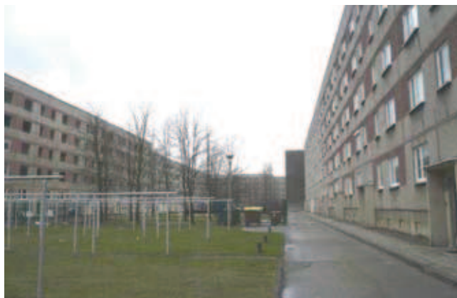
Rys. 7. Frankfurt nad Odrą marzec 2009; widok dziedzińca zabudowanego segmentami budynków prefabrykowanych – stan przed rozbiórką
