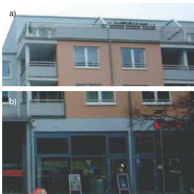
Rys. 2. Frankfurt nad Odrą 2004, wielkopłytkowy budynek przy Brunnenplatz; efektem przebudowy było m.in.: a) wprowadzenie tarasów na ostatniej kondygnacji i b) usług w parterze
