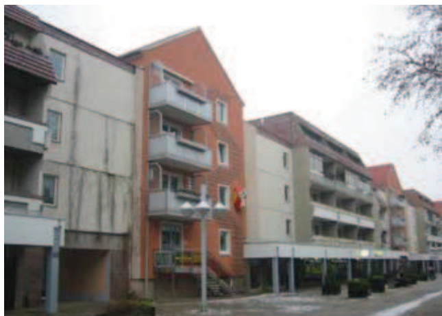
Rys. 3. Frankfurt nad Odrą 2004; widok po dobudowie balkonów o konstrukcji stalowej, montaż do ścian budynku, partery po wprowadzeniu usług
