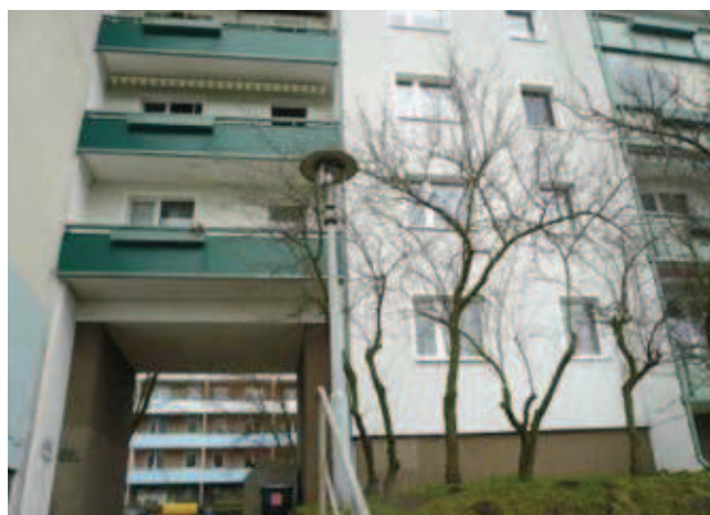
Rys. 9. Frankfurt nad Odrą 2009; budynek wielokopłytowy po modernizacji, dostawiono balkony nad przeszwitami
