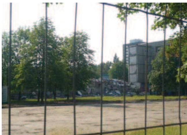
Rys. 8. To samo miejsce trzy miesiące później; lewe skrzydło w trakcie rozbiórki
