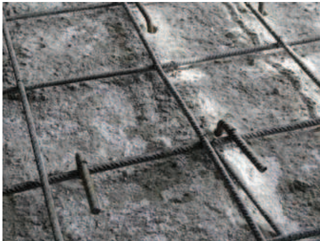
Rys. 3. Szczegół stropu z widocznymi prętami zbrojenia zespalającego
