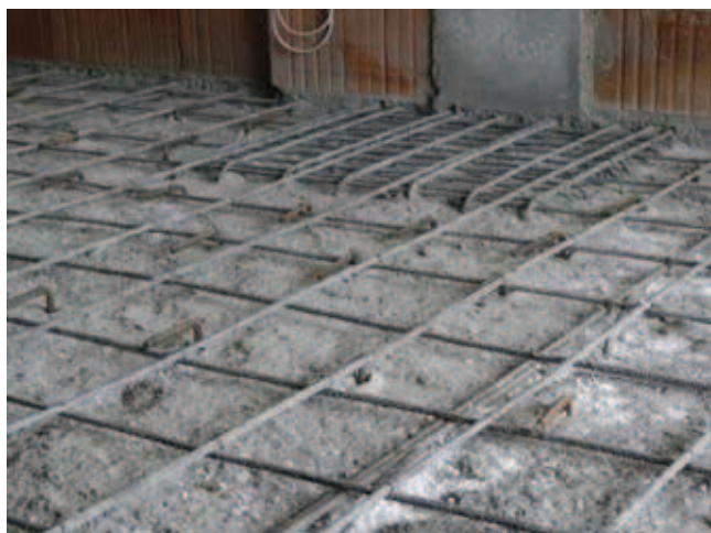
Rys. 2. Widok jednego ze stropów po usunięciu warstwy przemrożonego betonu
