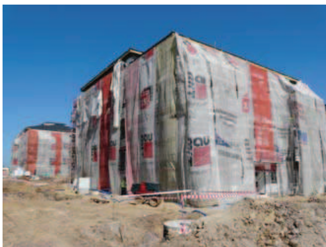
Rys. 1. Widok obiektów podczas budowy: na pierwszym planie budynek A, w głębi budynek B
