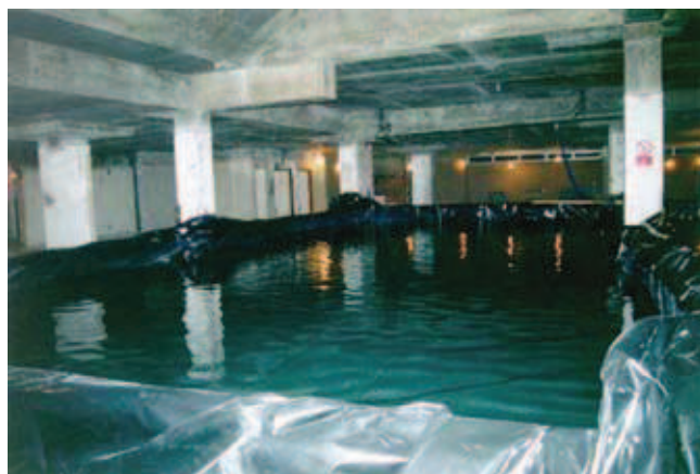
Rys. 2. Specjalna wanna dla gromadzenia wody jako obciążenia próbnego [3]
