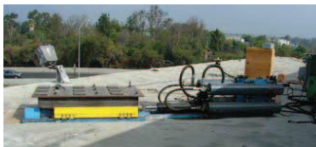
Rys. 6. Wibratory ustawione na dachu budynku [10]
