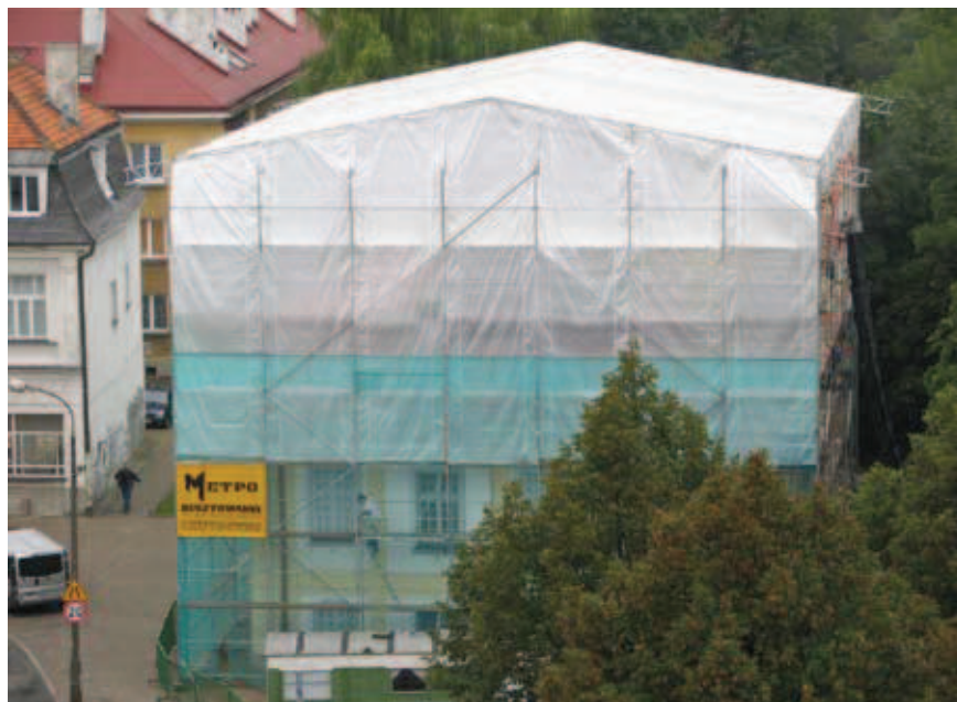
Rys. 3. Widok robót związanych z adaptacją i przebudową strychu w istniejącym budynku
