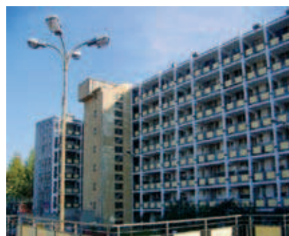
Rys. 1. Widok na segment galeriowca z Osiedla Młodych w Warszawie [2]
