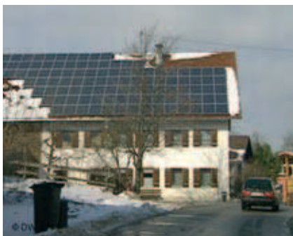
Rys. 8. Niemcy. Połaciowe usytuowanie paneli słonecznych w budynku 11
