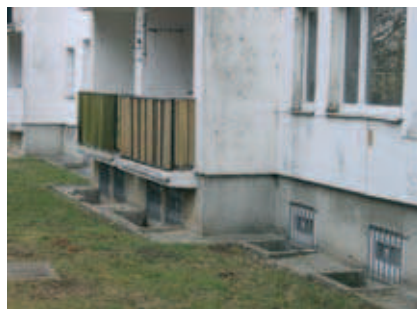
Rys. 3. Harnasie 3. Fragment budynku prefabrykowanego z 1980 roku po ociepleniu w latach 90. i częściowej wymianie stolarki okiennej
