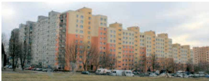
Rys. 14. Harnasie 21 / Zakopiańska 1. Budynek prefabrykowany z roku 1986 po ociepleniu w latach 90. i częściowej wymianie stolarki okiennej. Widok ogólny od strony północno-wschodniej
