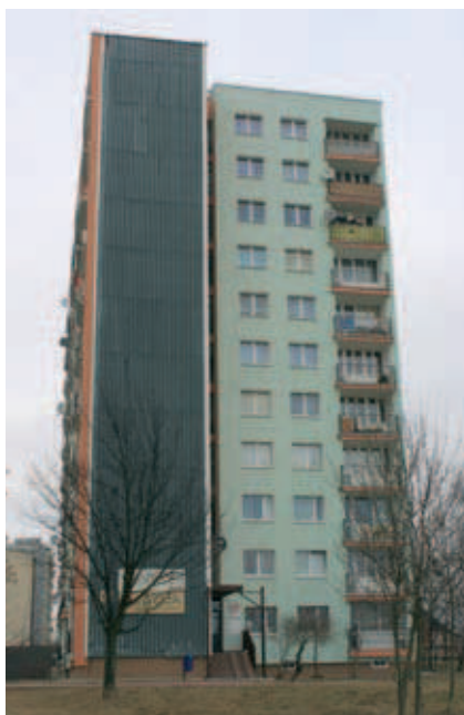
Rys. 20. Króla Rogera 6. Budynek prefabrykowany z 1986 roku po ociepleniu w latach 90. i częściowej wymianie stolarki okiennej. Możliwość montażu solarów i paneli fotowoltaicznych. Widok ogólny od strony południowej
