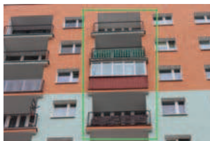
Rys. 21. Fragment elewacji zachodniej po II etapie ocieplenia. Widok zabudowy loggi cofniętej, patrz termogram rys.22
