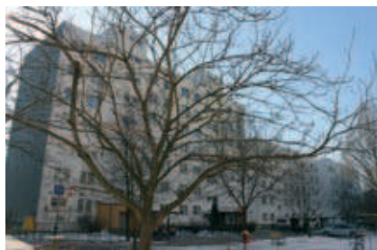
Rys. 9. Harnasie 19. Budynek prefabrykowany z 1983 roku po ociepleniu w latach 90. i częściowej wymianie stolarki okiennej
