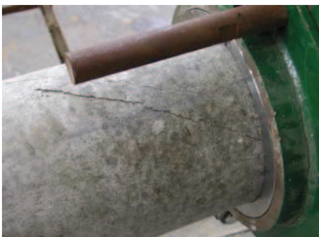
Rys. 5. Rysy ukośne w strefie szczytowej żerdzi
