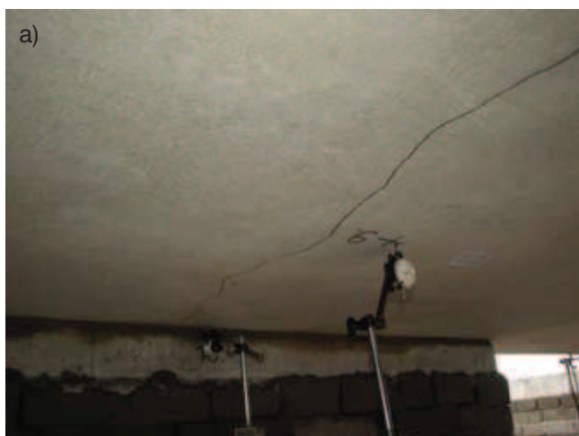
Rys. 10. Rysy pierwotne na powierzchni płyty audytoryjnej: a) poprzeczna na dolnej powierzchni płyty, w środku rozpiętości elementu, b) pionowe na bocznej powierzchni belki głównej
