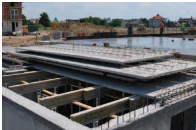
Rys. 1. Prefabrykowana płyta stropowa typu Filigran
