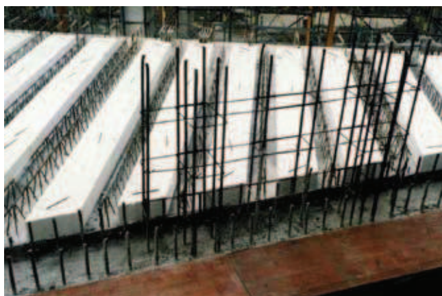
Rys. 2. Wkładki styropianowe zmniejszające ciężar stropu
