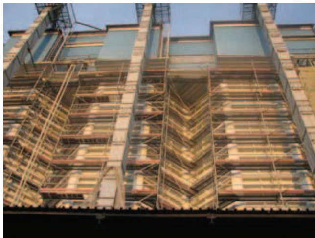
Rys. 6. Remont baterii prefabrykowanych silosów
