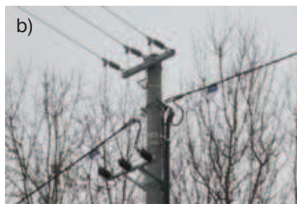
Rys. 3. Poprzeczniki stacyjne typu: a) PKZ-1b do przewodów gołych, b) PK-11a do przewodów niepełnoizolowanych
