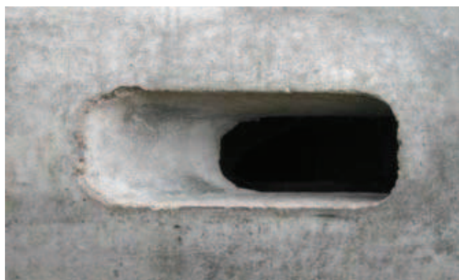
Rys. 4. Szczelina wlotowa kabli
