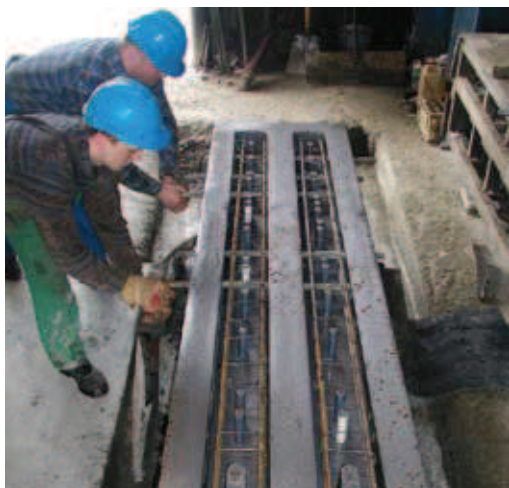
Rys. 1. Zbrojenie żerdzi ŻN/200 w stalowej formie bateryjnej (dwuelementowej)
