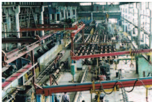
Rys. 2. Widok na halę produkcyjną żerdzi wirowanych w PPSZW Wirbet Ostrów Wielkopolski (czerwiec 1993 r.)
