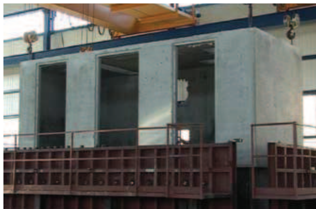
Rys. 3. Obudowa stacji KSW w trakcie wyjmowania z formy (podłoga jest na górze). Po odwróceniu i malowaniu przybierze postać jak na rysunku 2
