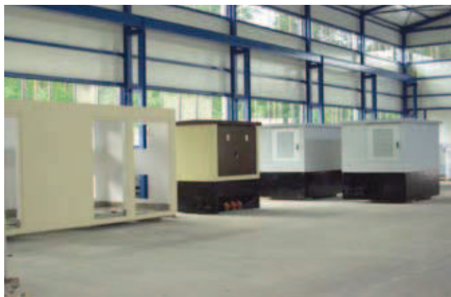
Rys. 2. Żelbetowa obudowa stacji KSW przygotowana do montażu wyposażenia. Obok stoją dwie kompletne stacje KSW
